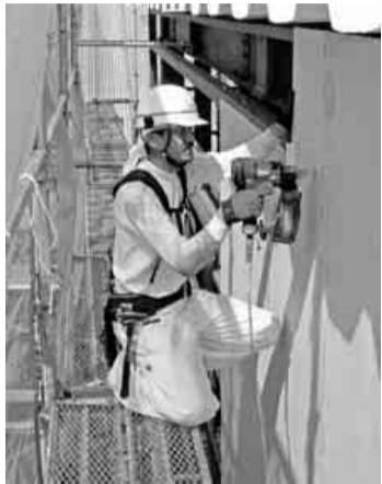
外壁工事をしている上田幹事
