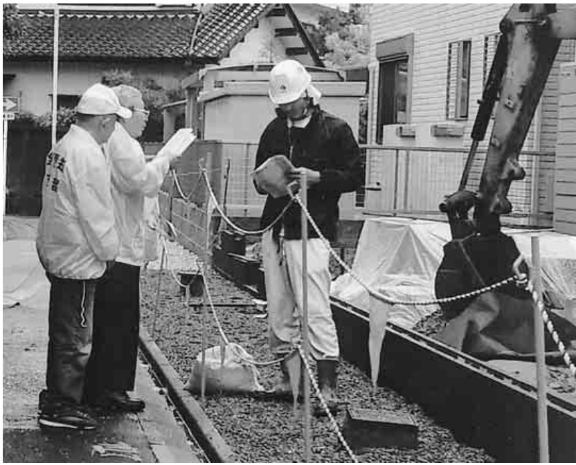
建設現場を訪問し組合の説明をする役員(左)
