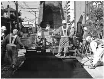
舗装工事をする作業員の方々
